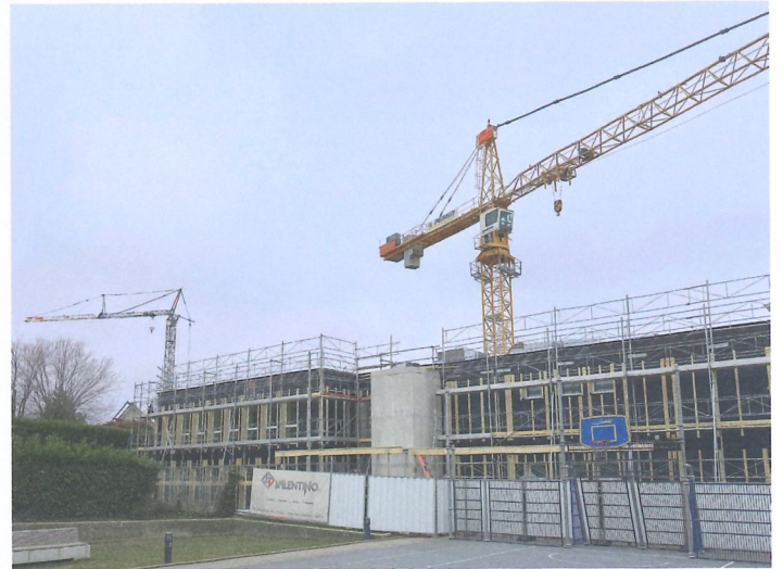
Chantier de l'école / Photo : W. Jaques
