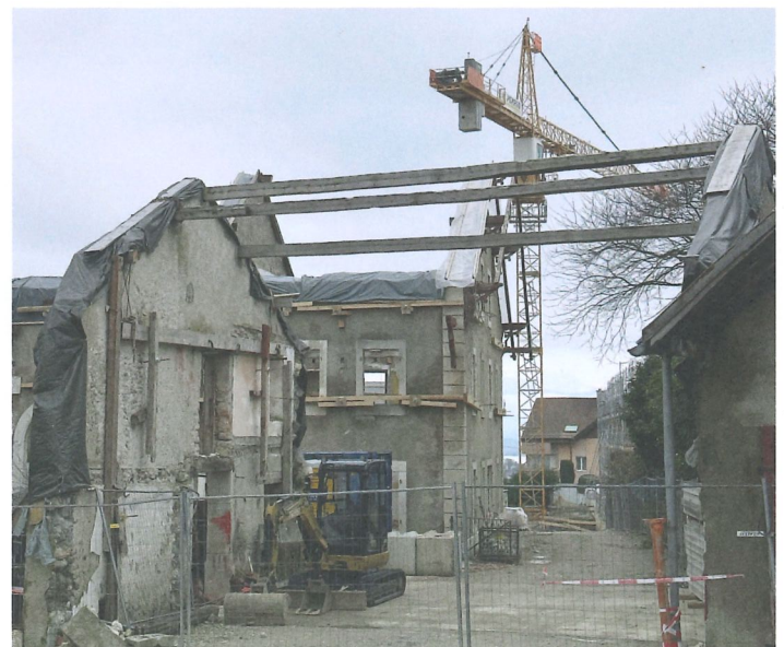
Le chantier de la rue des Trois Fontaines / Photo : W. Jaques
